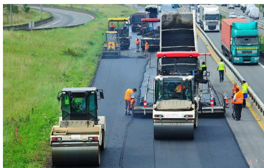
Le principe des travaux est de remplacer les couches supérieures de la chaussée qui sont en cours de désagrégation par de nouveaux matériaux bitumeux de 18 cm d'épaisseur.
